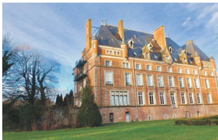
La façade méridionale du château de La Motte-au-Bois.
